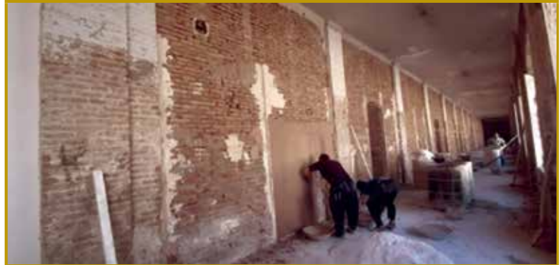
راهروی غربی از طبقه همکف (حین مرمت)
