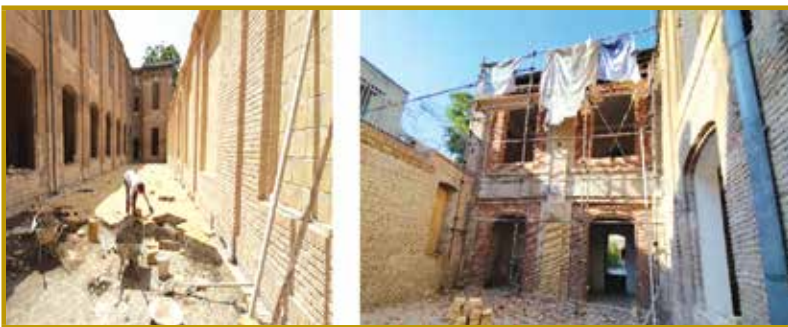
وضعیت دیوار حیاط غربی حین اقدامات مرمتی
