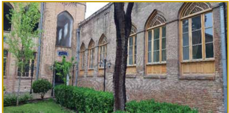
نمای جنوب غربی از حیاط مرکزی
