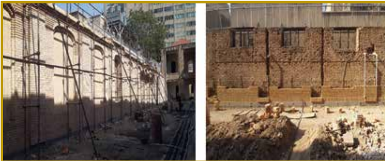
وضعیت دیوار حیاط غربی حین اقدامات مرمتی
