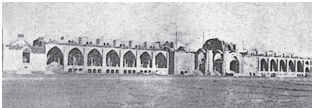
دبیرستان ایرانشهر در حال احداث؛ (سال ۱۳۱۵)
